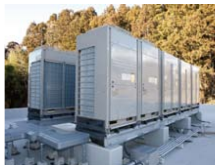
電動ヒートポンプ (個別分散)
