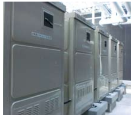
冷温同時取出ヒートポンプ
