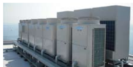
電動ヒートポンプ (個別分散)
