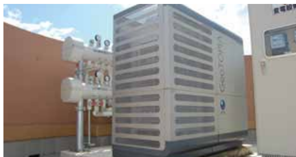
ハイブリッドヒートポンプ(水冷式、空冷式)
