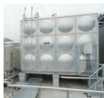
ヒートポンプ給湯
