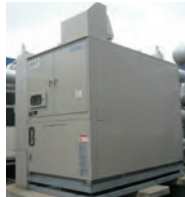
地中熱利用水熱源ヒートポンプ
