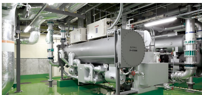
45℃排熱回収ダブルバンドル式ターボ冷凍機を採用
