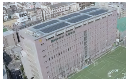
校舎屋上 太陽光パネル
