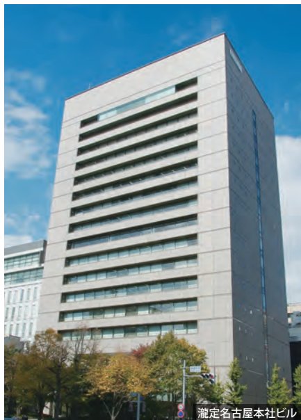
瀧定名古屋本社ビル
