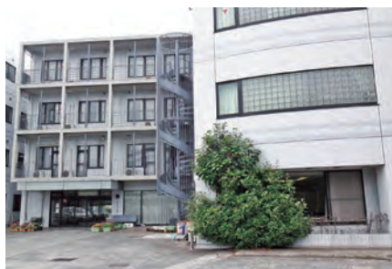
式番館 53室 67名 敷地内の広い駐車場を挟んで介護が必要な方のお住まい。特別浴室、ご家庭のような個別浴室など身体状況に応じた入浴サービスが受けられる。
