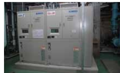
排熱回収ヒートポンプ
