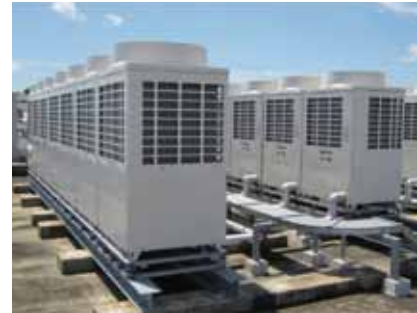
電気式ヒートポンプ(個別分散)
