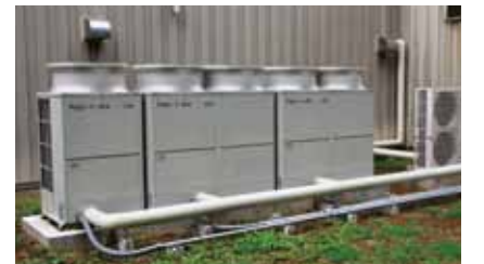
電気式ヒートポンプ(個別分散)
