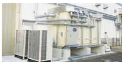
インバータスクロール冷凍機と蓄熱槽
