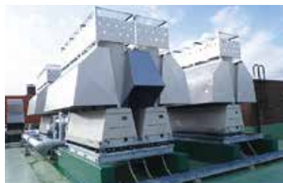
寒冷地対応空冷ヒートポンプチャラー
