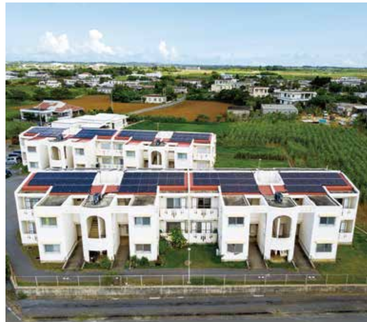
市営住宅の屋上には太陽光パネルが設置されている
