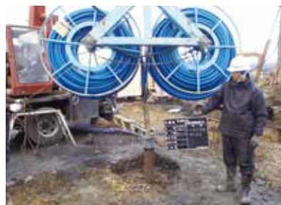
地中熱交換器設置
