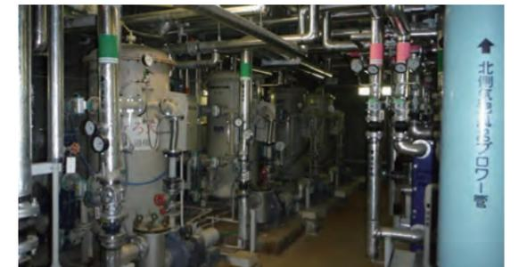
浴槽加温用の高効率熱交換器を既存濾過加温システムに加えた様子(改修前)
