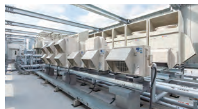
業務用エコキュートと空気熱源ヒートポンプチャラー
