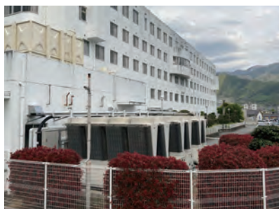
超高効率型空冷ヒートポンプチャラー
