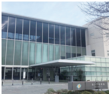
泉南市総合福祉センター(あいぴあ泉南)
