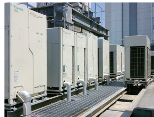
空冷ヒートポンプマルチパッケージ型空調機
