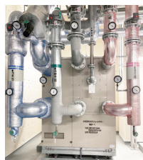
水熱源熱回収 インバータスクリーチャー
