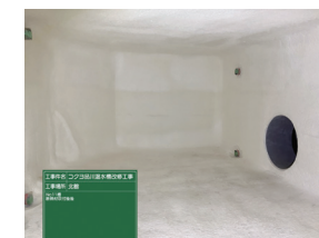
断熱材吹付後
