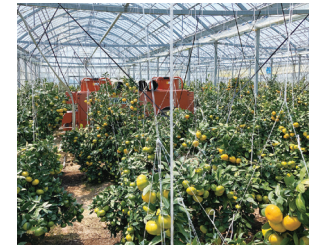
ハウス内に設置された温風装置
