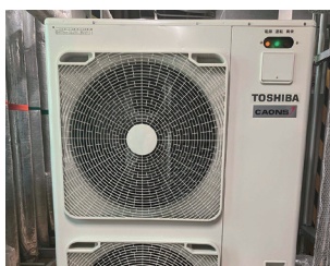
循環加温ヒートポンプ熱源ユニット
