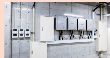
太陽光発電の電気をシステム運用するためのパワーコンディショナ
