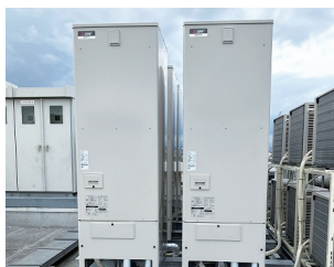
ヒートポンプ給湯機
