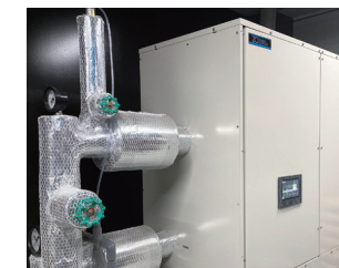
地中熱源対応水冷式ビル用マルチシステム室内ユニット
