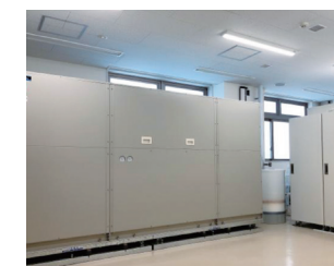
透析熱回収ヒートポンプシステム
