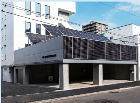
太陽光発電パネルは5か所に設置され、合計207枚、総発電量は94.19kW。発電した電気は自家消費している。
