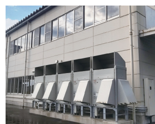
空冷ヒートポンプ式ビル用マルチエアコン
