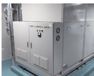
地中熱対応水冷式ヒートポンプチャラー
