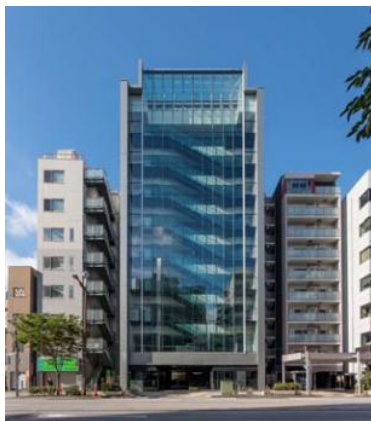
須賀工業本社ビル外観（写真：クドウフォト）
