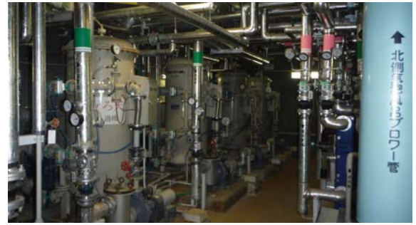
浴槽加温用の高効率熱交換器を既存濾過加温システムに加えた様子(改修前)
