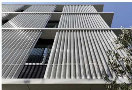
東面：有孔パネル
