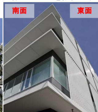
南東角外観（庇の違い）
